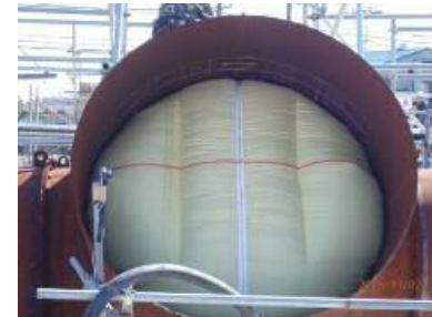
展開完了(上流側)
