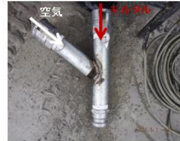
写真1 空気/モルタル投入接続配管
