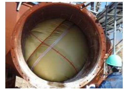
展開完了(ベントヘッダ側)
