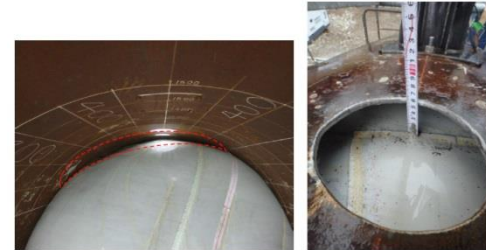
図3 閉止補助材とベント管上部の隙間
