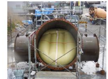
写真4 モルタル充填後
