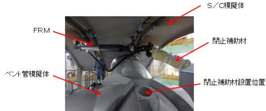
写真1 FRMによる閉止補助材の移送
