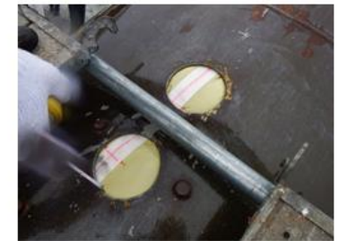
写真6 モルタル充填後(ベント管上部)
