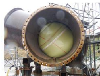
写真5 モルタル充填後(ベントヘッド側)
