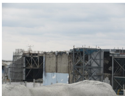
原子炉建屋（3号機）の状況
