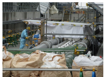
凍土壁凍結状況確認箇所の状況
