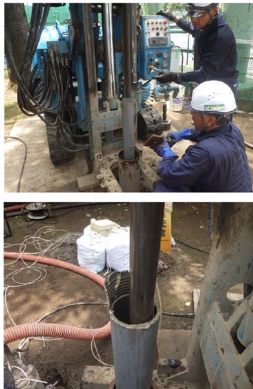
図9 観測井戸管材の回収方法(左)、パッカーを利用した回収状況(右)
